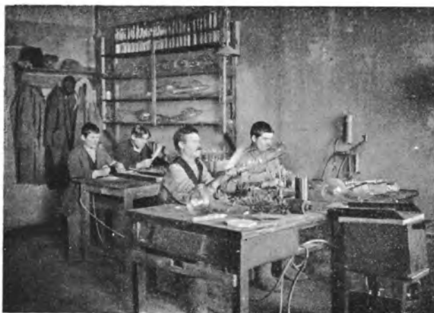
De werkplaats van het Russische radio-laboratorium, waar de lampen gemonteerd worden vóór het vacuumproces.
